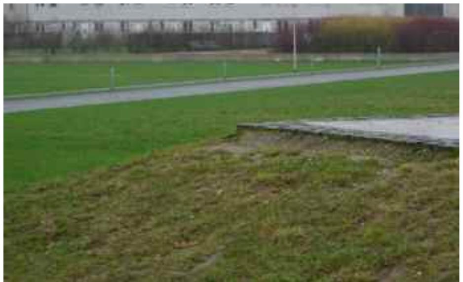
Der Anschluss der Böschungseigung an die Betonkante funktioniert nicht. Nachträglich müssen bauliche Änderungen zur optischen Verbesserung und Pflegbarkeit erfolgen.
