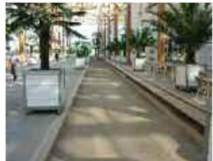
Boulebahn im Gebäudeinneren – Sonderfall einer wassergebundenen Decke
